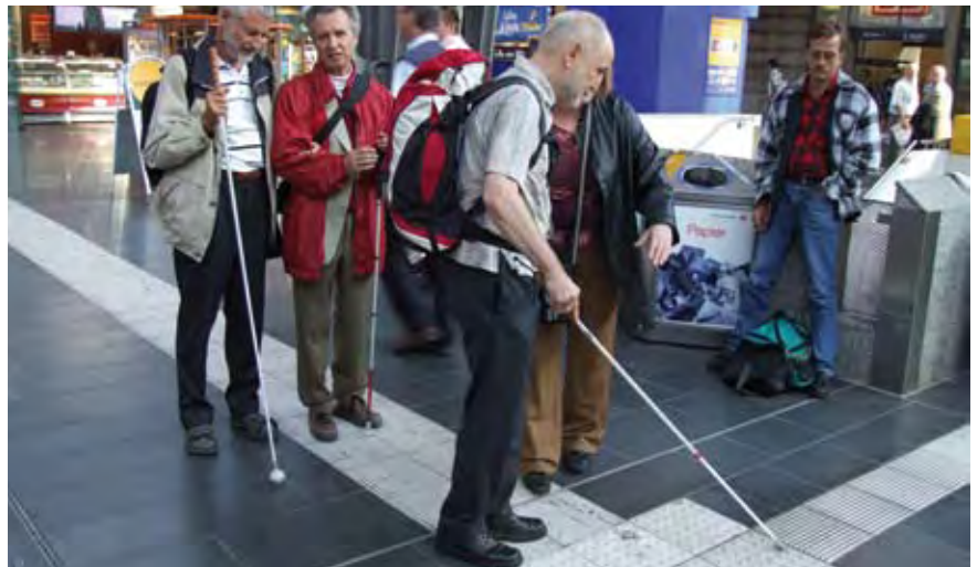
Taktiler Leitsystem, kontrastreich ausgeführt.
