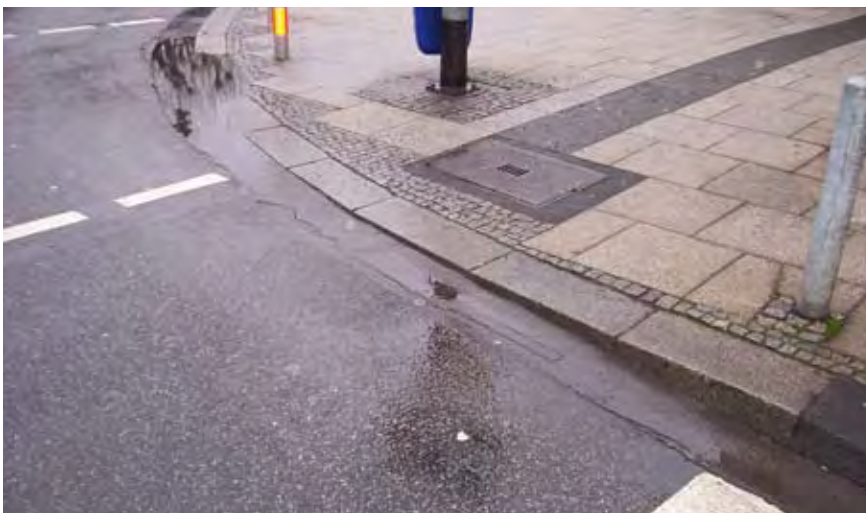
Variierende Bordhöhe bei alten Anlagen.
