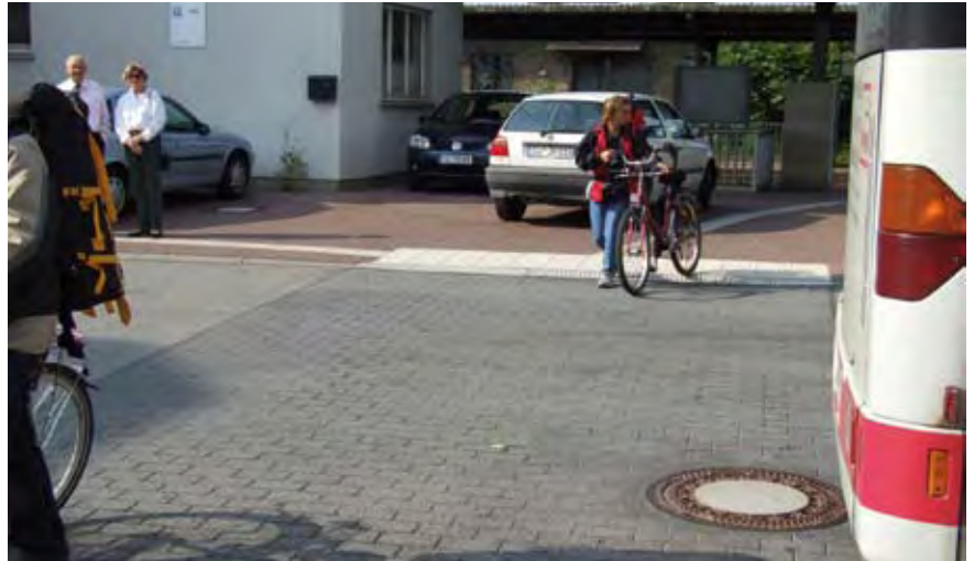
Nullabsenkung am Bahnhofplatz Eltville am Rhein. 🚲 F2
